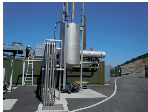
Espace d'enfouissement actuel et installation de production d'électricité à partir du bio-gaz
