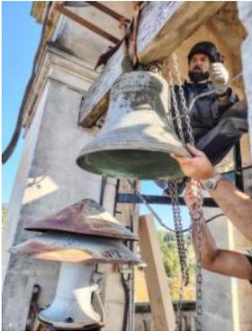
À la suite de la visite de maintenance annuelle de l'installation campanaire, il a été constaté que la poutre de support d'une des cloches de l'église était vieillissante. Afin d'assurer la sécurité de la cloche et du bâtiment il a été préconisé de remplacer cette poutre.
